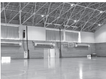
暖房設備をガス式に変更した体育館内。広々として、見た目もすっきり
